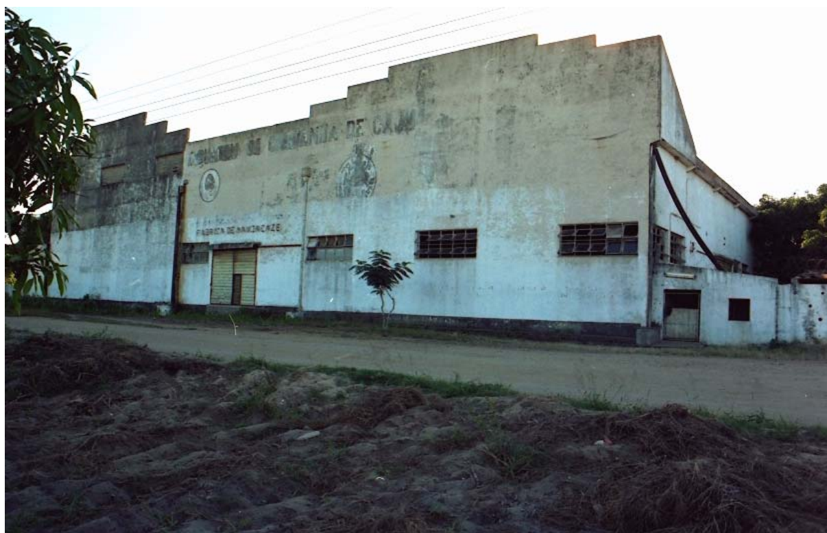
Fotografia 13. Fachada principal da fábrica velha
