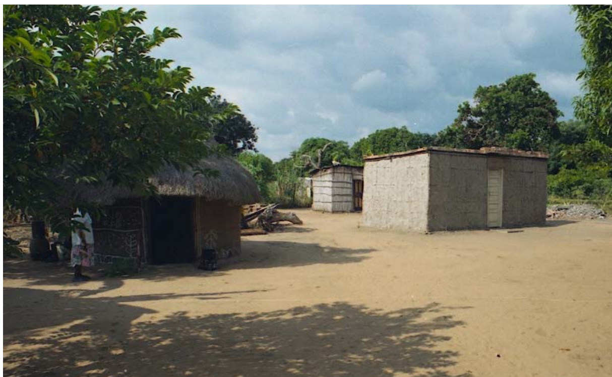
Fotografia 6. Habitação de construção tradicional melhorada em Manjacaze
